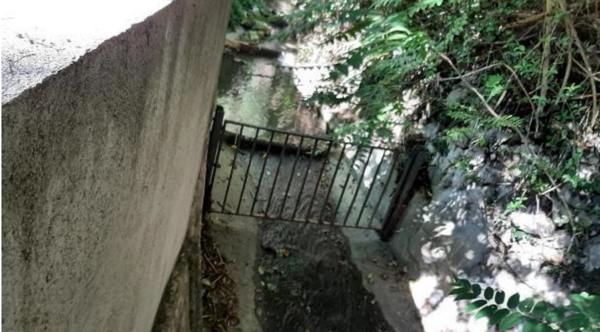
Figure 15 : piège à embâcles rue des Martyrs (ouvrage4).
